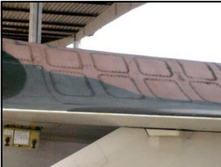
Nesta foto pode ser vista a acentuação na divisão dos painéis
